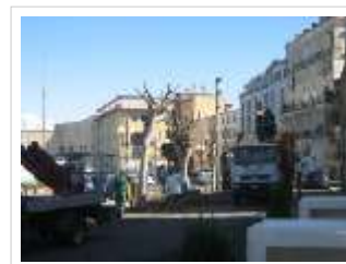
Operai della De Vizia al lavoro in via Bausan
